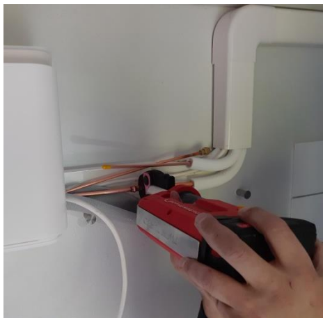
Krympning af rør
