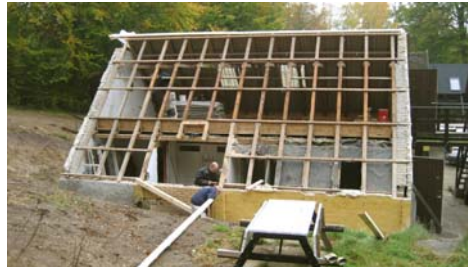
Bølgetaget er fjernet. Spærene genopbygges
