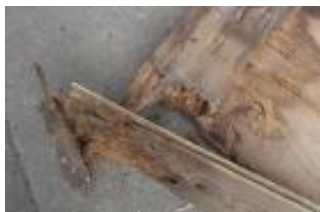
Det var ikke overflødigt at fjerne klædningen
