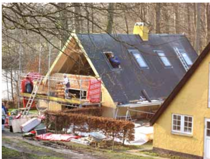
Barak 5 under opførelse (8. februar 2007)
