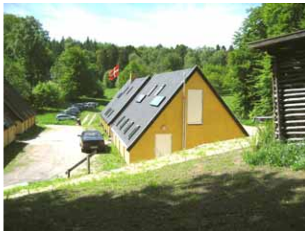
Barak 1 og 4 med nye tage og vinduer.
