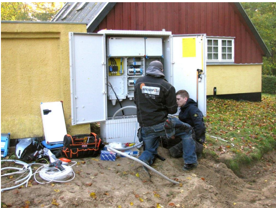
Arbejde med opsætningen af et nyt målerskab
