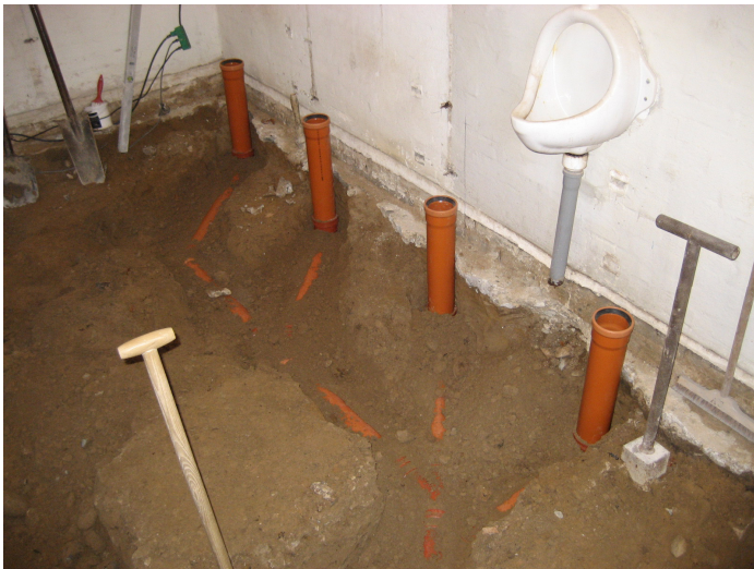
Rør til afløb for nye håndvaske
