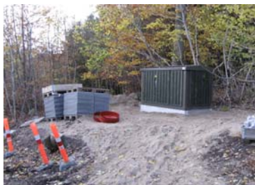
Gammel spændingsforhøjer og ny transformer ved Bommen til Rude Skov
