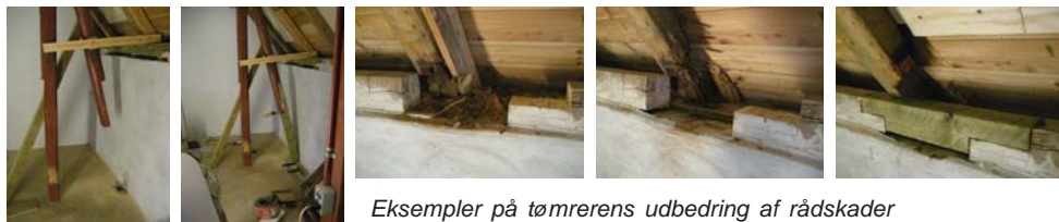
Eksempler på tømrerens udbedring af rådskeer
