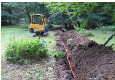
Vort kabel nedgraves (i røt) og trækkes ned fra Nordvestlågen
