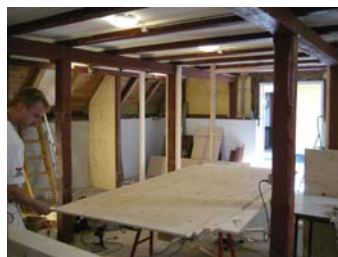
Nye skille-vægge, D-messen begynder at tage form
