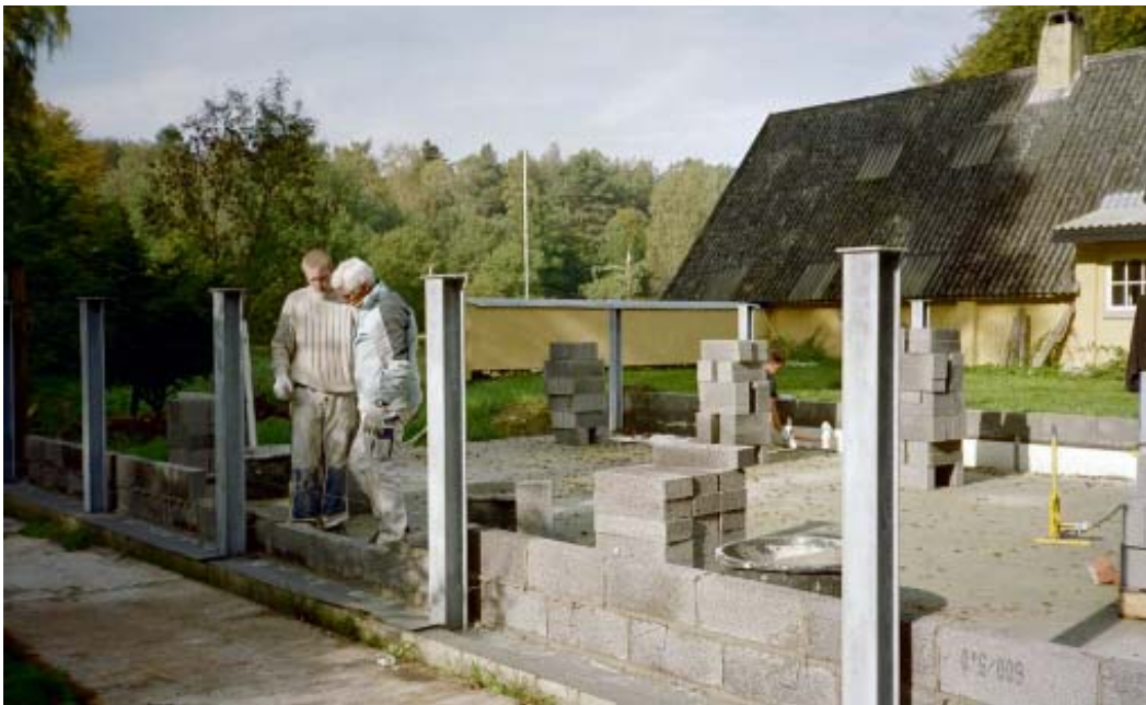
18. oktober: Murerarbejdet er netop påbegyndt, udsigten til de gamle bygninger skjules.
